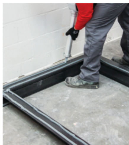
08 Užtepkite klijus ant rėmo, 2 nepertraukiamomis juostomis
