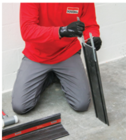
04 Sujunkite 2 rėmo elementus ar atraižas sujungiamosiomis jungtimis
