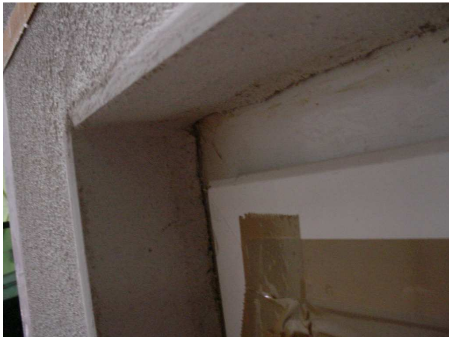
Bild 6 Leibungen verputzt mit Kellenschnitt zum Blendrahmen.
