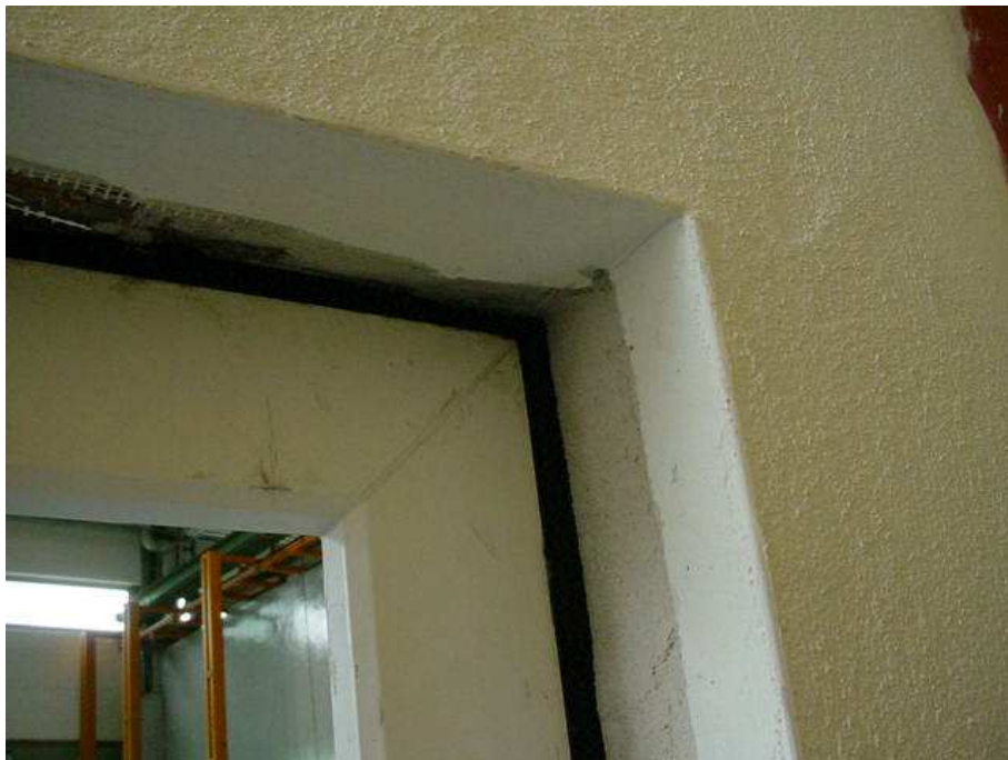
Bild 4 Außenseitige Abdichtung mit Soudaband PRO BG1, im Eckbereich stumpf gestoßen
