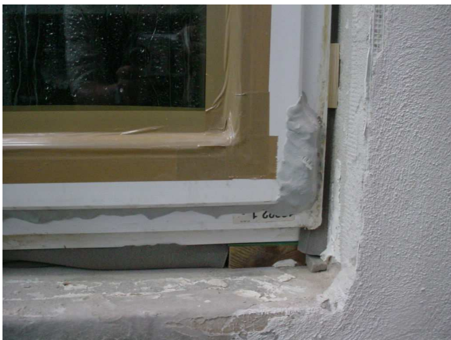
Bild 2 Fugendämmung mit Soudaband Acryl HF
