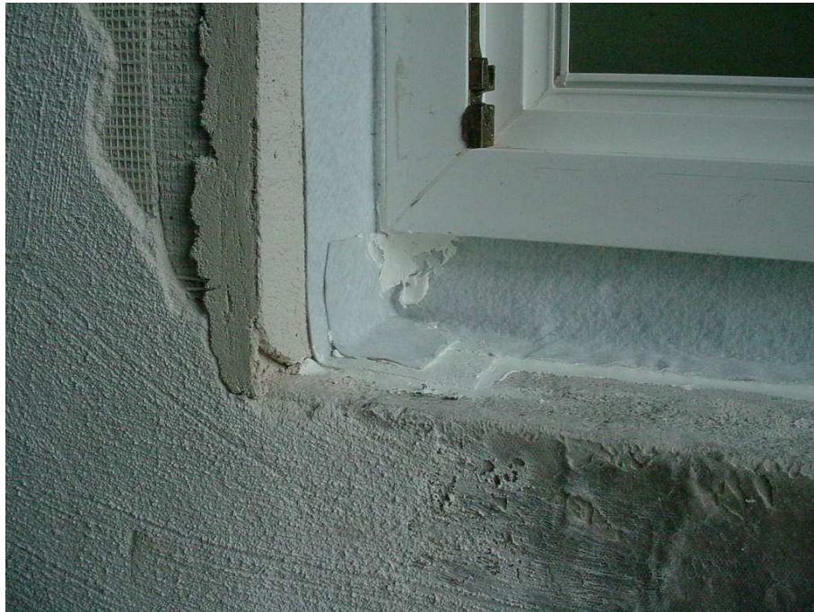
Bild 3 Raumseitige Abdichtung, untere Eckausbildung
