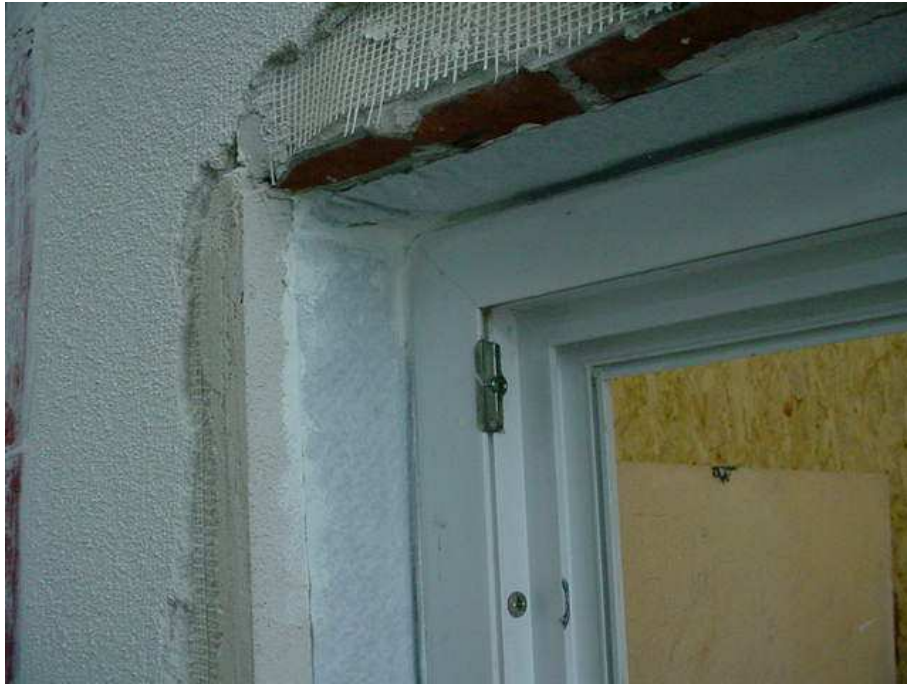
Bild 1 Raumseitige Abdichtung mit Fensterdichtband RS, Verklebung zum Baukörper mit Soudafoil 330D, überlappende Ausbildung im oberen Eckbereich
